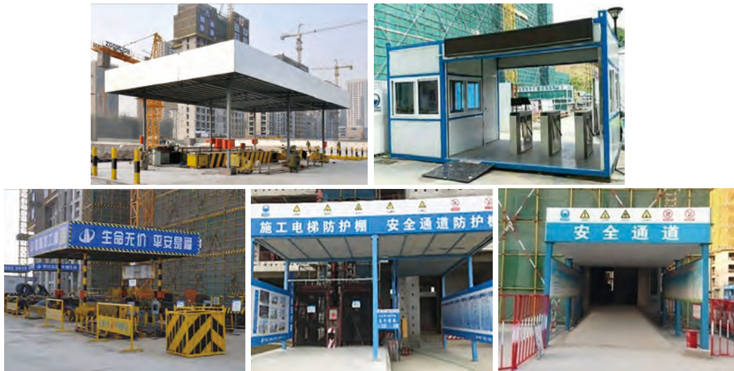
施工安全實拍
